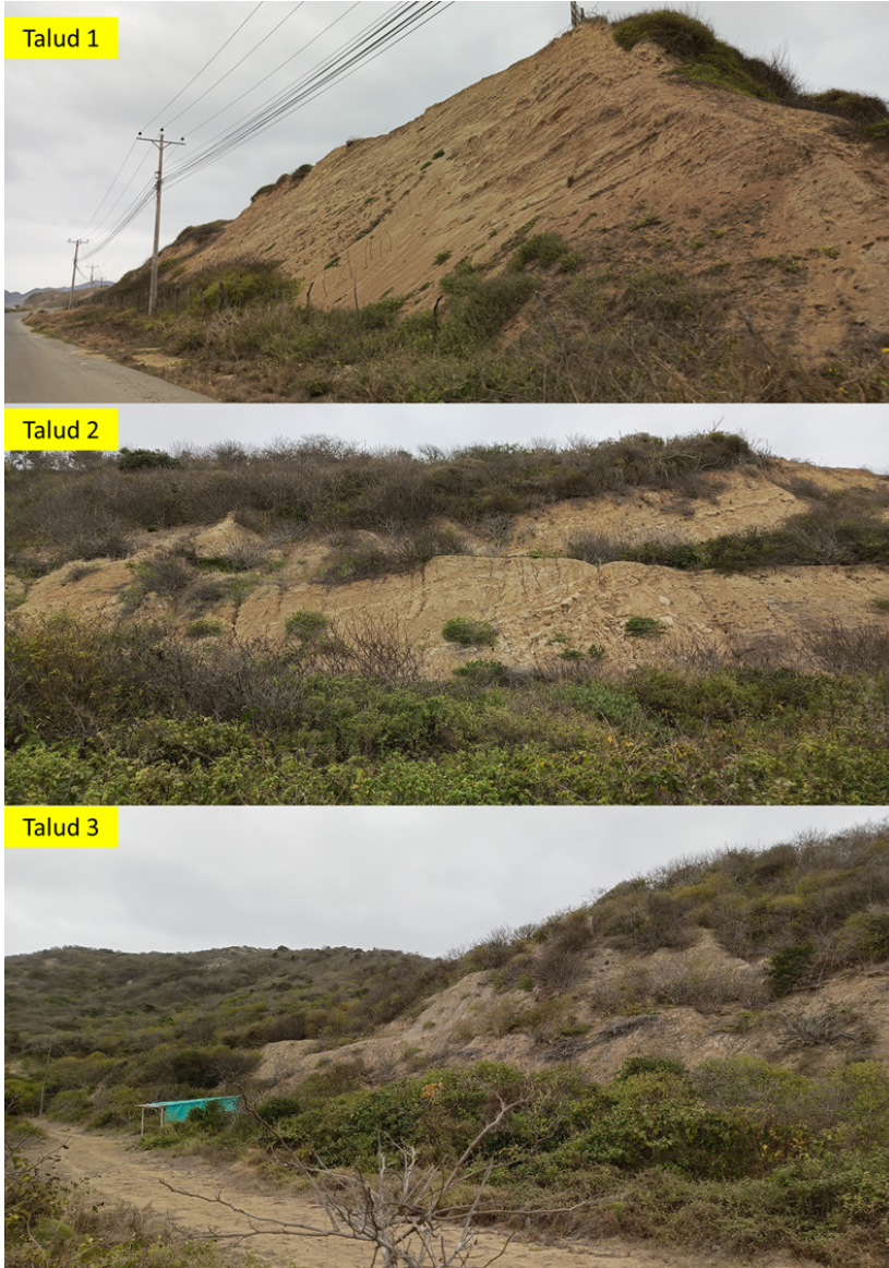
Figura 3.- Taludes dentro del lote y su cobertura vegetal.
