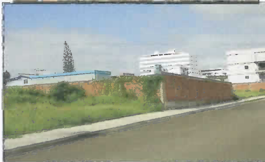
Vista del cerramiento construido por el Sr. Fernando Yépez Arboleda
