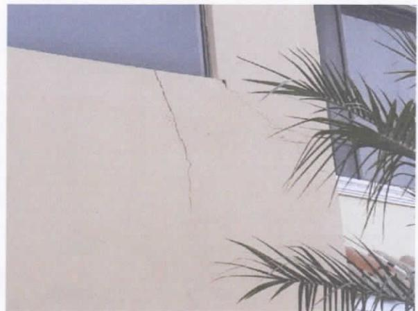
Como se puede observar las fisuras en la pared principal que tiene dos ventanales, esta pared tiene una altura aproximada de 6 m x 4 m aprox. separadas por una viga banda de 50x20. La norma Nec-15 recomienda la colocación de dinteles y columnetas alrededor de la ventanas o puertas, para evitar este tipo de fallas en mampostería.
