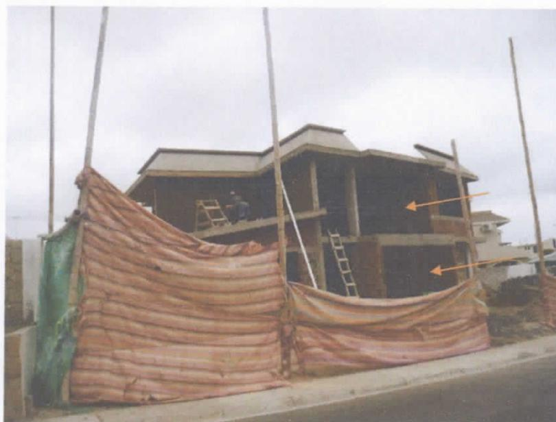
Como se puede ver en la foto la pared es separada por una viga banda de 50x20 cm, donde mediante inspección visual y foto facilitada por el dueño de vivienda Dra. Ana Cevallos se comprueba lo anteriormente dicho de que las ventanas no tienen dinteles y columnetas.
