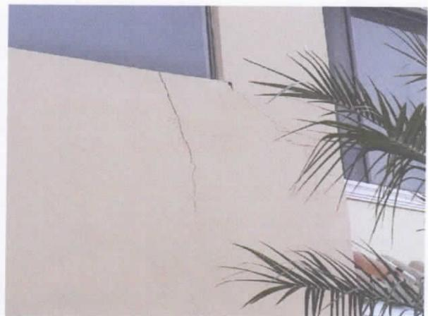
Como se puede observar las fisuras en la pared principal que tiene dos ventanales, esta pared tiene una altura aproximada de 6 m x 4 m aprox. separadas por una viga banda de 50x20. La norma Nec-15 recomienda la colocación de dinteles y columnetas alrededor de las ventanas o puertas, para evitar este tipo de fallas en mampostería.
