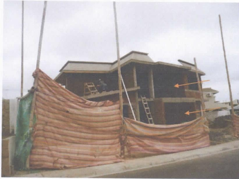
Como se puede ver en la foto la pared es separada por una viga banda de 50x20 cm, donde mediante inspección visual y foto facilitada por el dueño de vivienda Dra. Ana Cevallos se comprueba lo anteriormente dicho de que las ventanas no tienen dinteles y columnetas.
