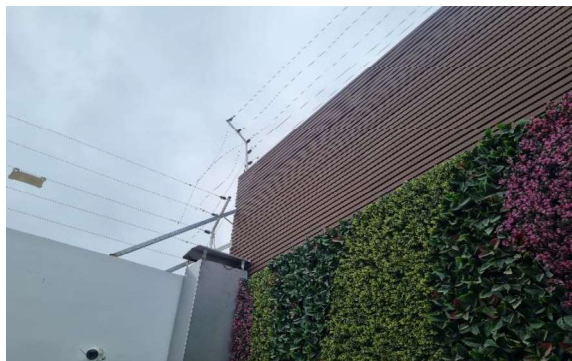
Vista de cerramiento y cerco eléctrico.
