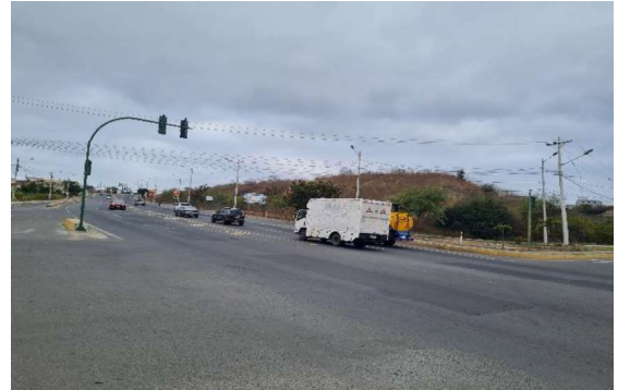
Vista de vía de acceso y entorno.
