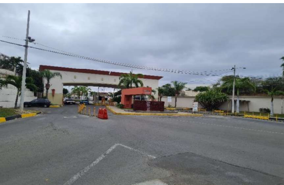
Vista de portón y garita de control e ingreso.
