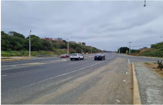
Vista de vía de acceso y entorno.
