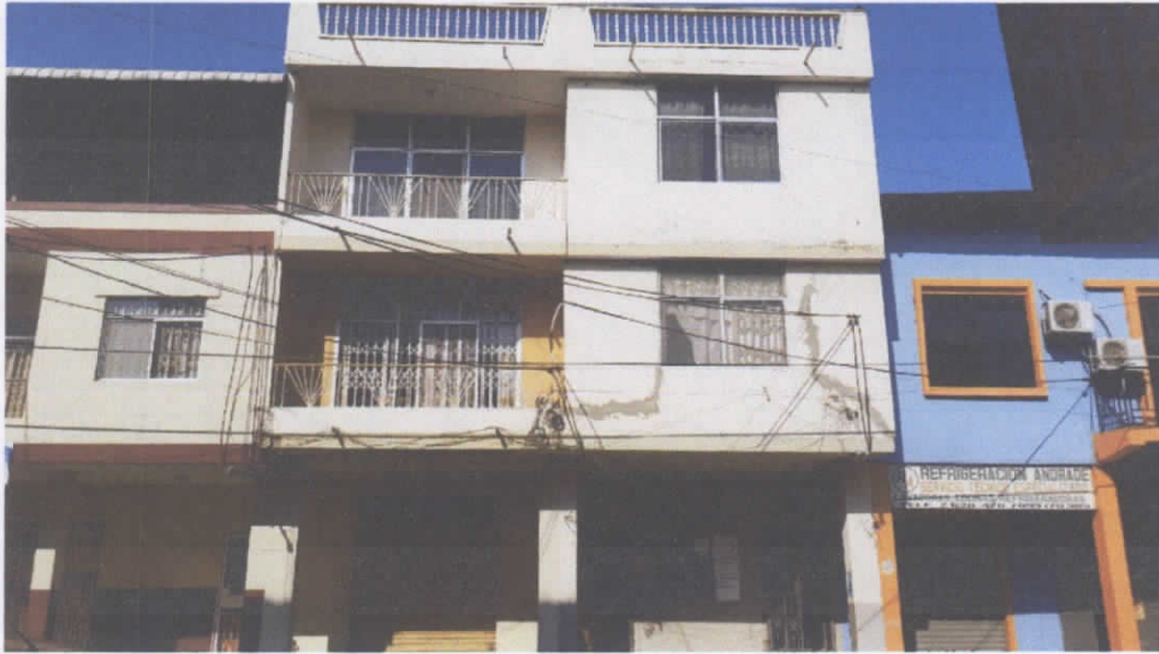
FACHADO FRONTAL DEL EDIFICIO CEDEÑO RUÍZ
