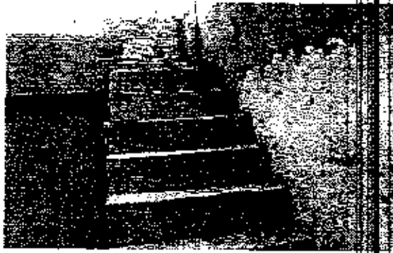
FOTO: Vista de escalera
