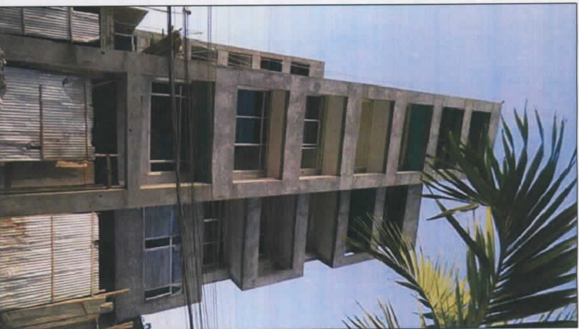
VISTA HACIA LA FACHADA SUR
