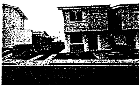
VISTA DE LA VIVIENDA
