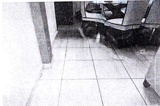
COLUMNAS PLANTA BAJA
