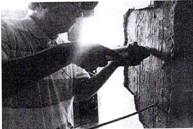
COLUMNAS PLANTA BAJA
