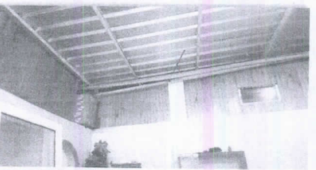
DETALLE DE TECHO
