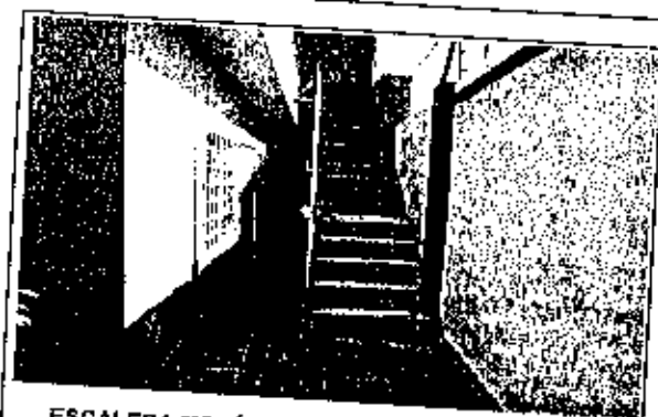
ESCALERA METÁLICA, ACCESO A PLANTA ALTA
