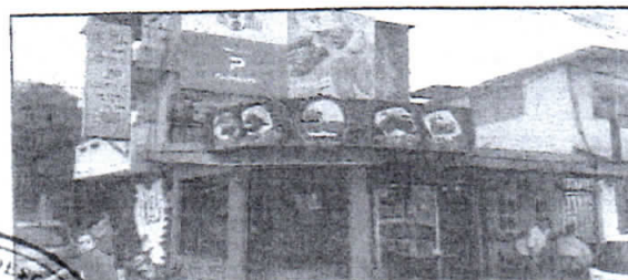
IMAGEN FRONTAL - VIA CIRCUNVALACION
